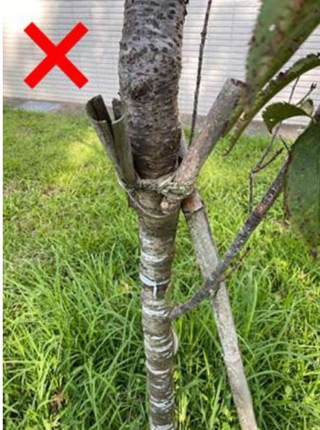
▲ 支架已斷裂失去支持功能。
